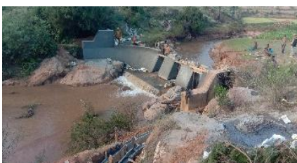
Réhabilitation d'un barrage
