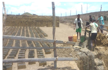
Un jeune avec l'aide de sa famille prépare des briques pour la construction du futur bâtiment d'élevage
