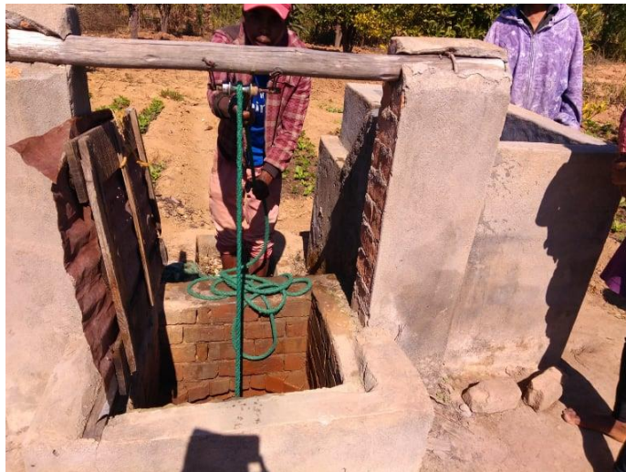
Figure 7: puits implanté dans les formations alluvionnaires, Alatsinainy Ambazaha
