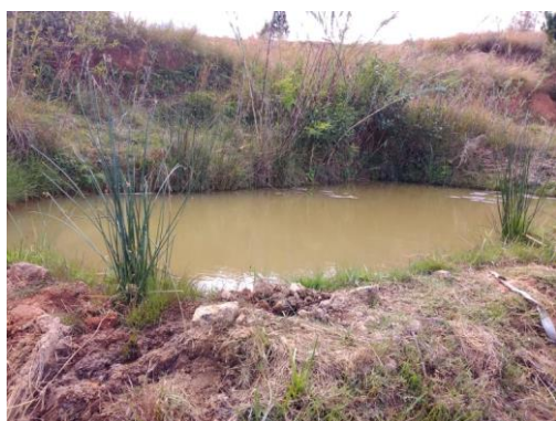
Figure 5: bassin de rétention en terre, respectivement Manazary et Andranomiely
