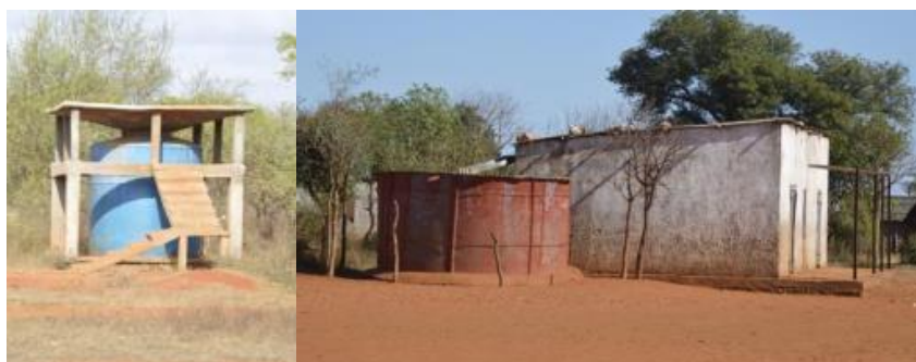
Figure 8: différents types d'impluvium dans le Sud de Madagascar. Source : Rasoloariniaina, 2016
