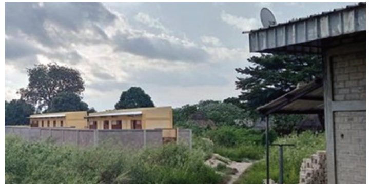
Les nouvelles latrines vues du Centre Culturel de Koumogo, à la fois proches et bien à l'abri des regards. Une grande avancée pour les filles et les femmes.
