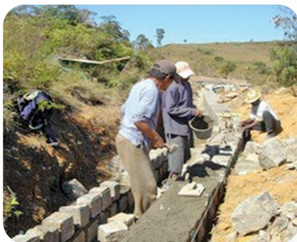
Construction d'un mini barrage à Ambatomasina (Madagascar Hilfe)
