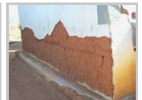
Usure régulière des murs en matériaux locaux après plusieurs saisons des pluies
