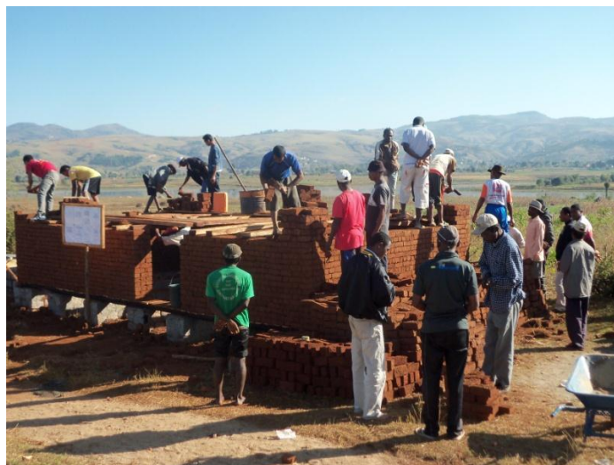
Photo 1 : travaux pratiques : maçonnerie de briques
