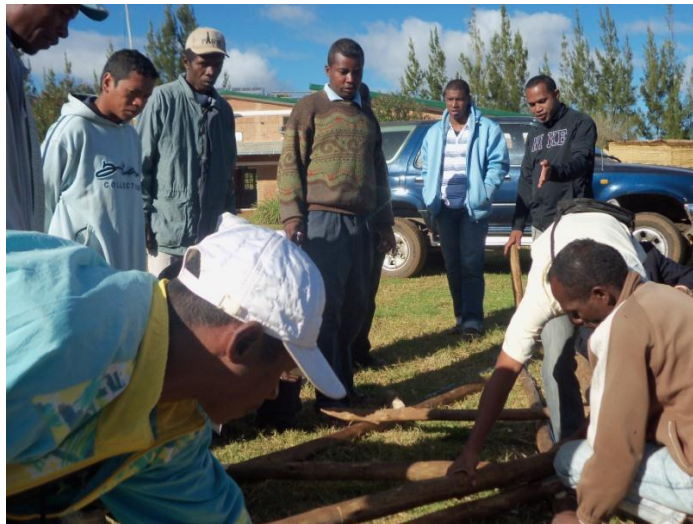
Photo 3 : travaux pratiques : assemblage d'une ferme
