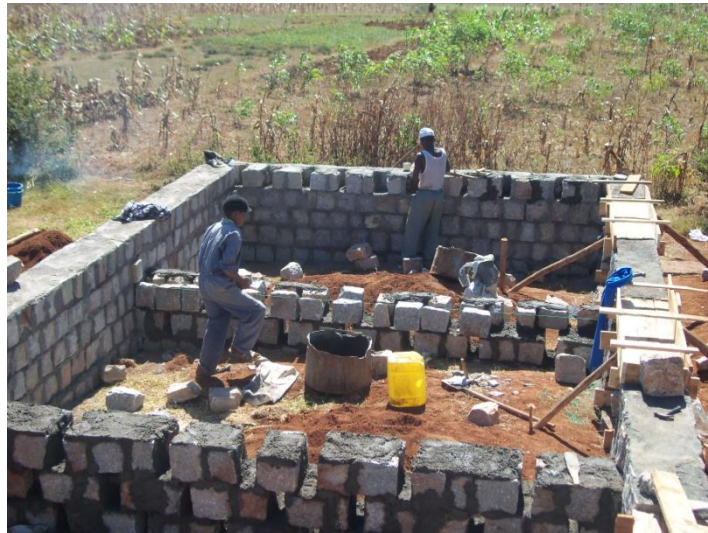
Photo 1 : exemple de fondations en maçonnerie de moellons
