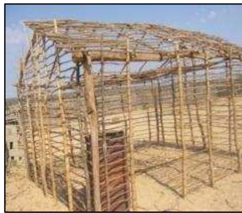
Photo 10 : Charpente en bois pour un sol plus sableux Source : auteur, 2010
